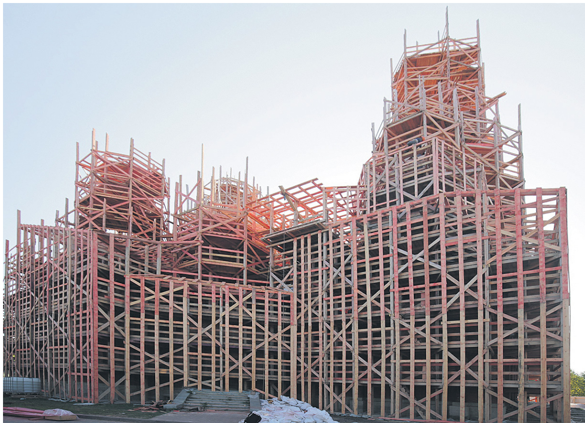
Высота строительных лесов на храме – 30 метров.
