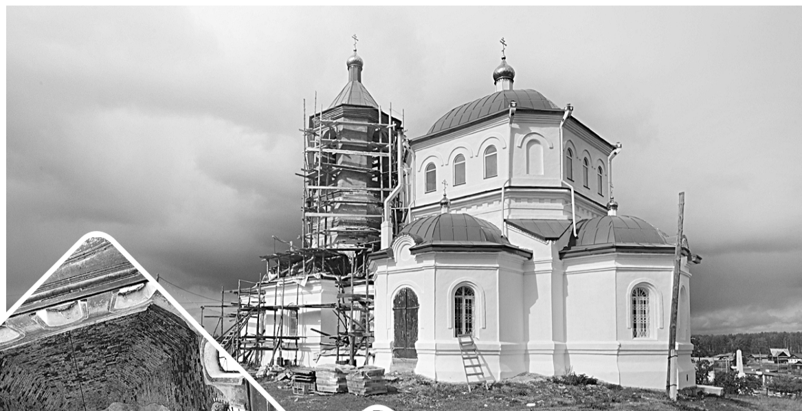
Старинный храм Святой Троицы в Ларино снаружи практически готов. Осталось оштукатурить колокольню.
