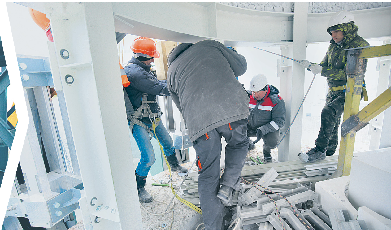
Монтажники ловят на болты верхнюю часть «ребра».
