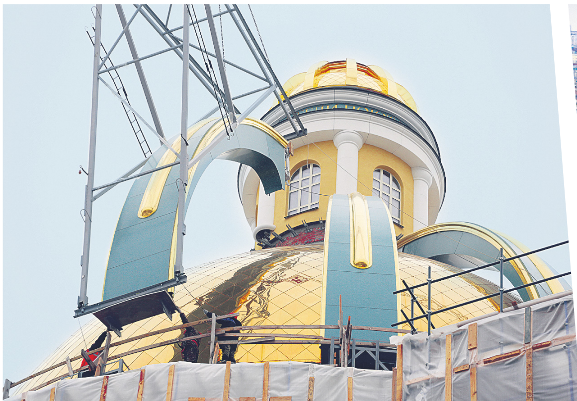
Подача «ребра» в проектное положение.
