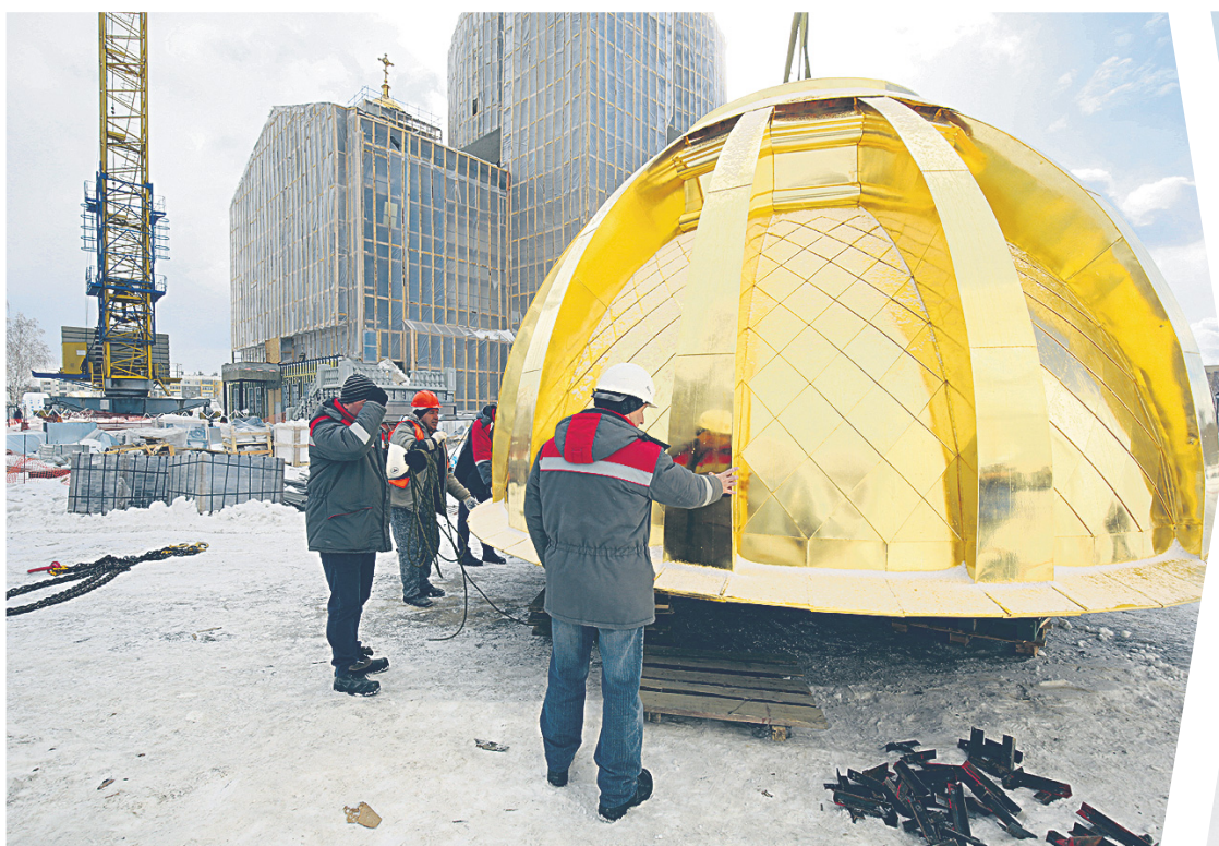
Перед подъемом главки нужно проверить правильность строповки. Для этого главку приподнимают и осматривают со всех сторон.
