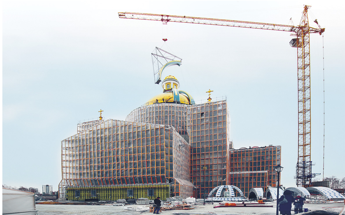
Монтаж декоративного «ребра». Стрела крана настроена горизонтально. Когда придет время устанавливать крест, стрелу закрепят в вертикальном положении.
