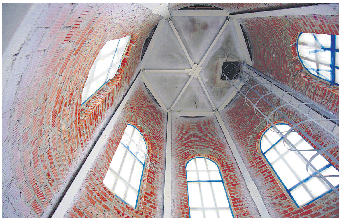
Вот так выглядит малый барабан центральной главки изнутри. По лестнице монтажники взбираются на самую верхнюю точку собора.
