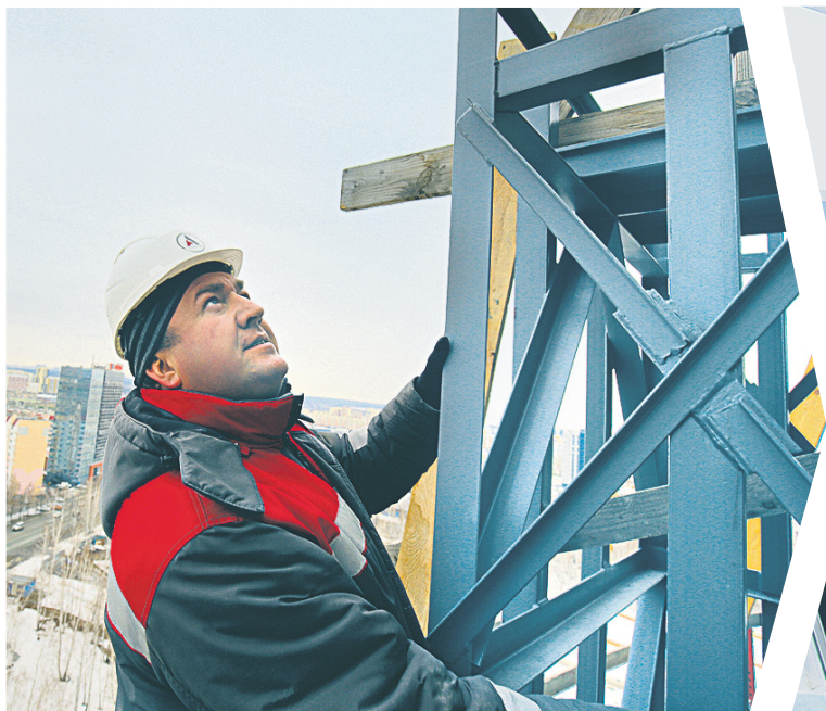
Ведущий инженер по техническому надзору за строительством Алексей Дзюба следит за процессом присоединения нижней части «ребра». Дело происходит на 40-метровой высоте.
